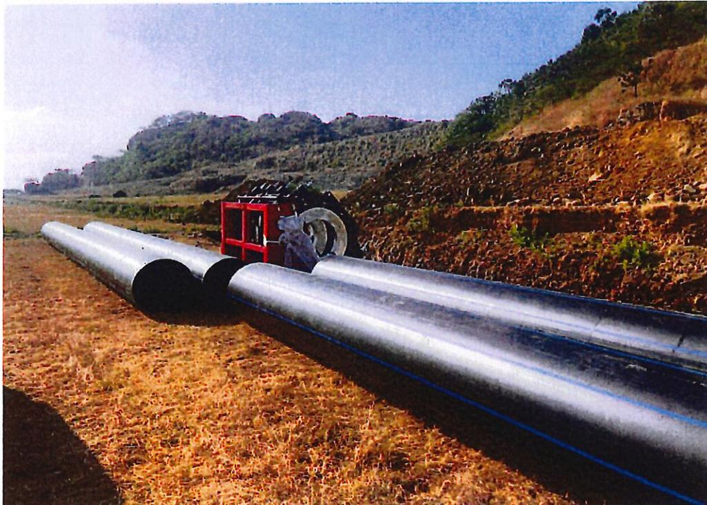
Sum. TUBO, 710mm, PEAD PE 100 RC, PN 6, PARA UNION POR TERMOFUSIÓN.
